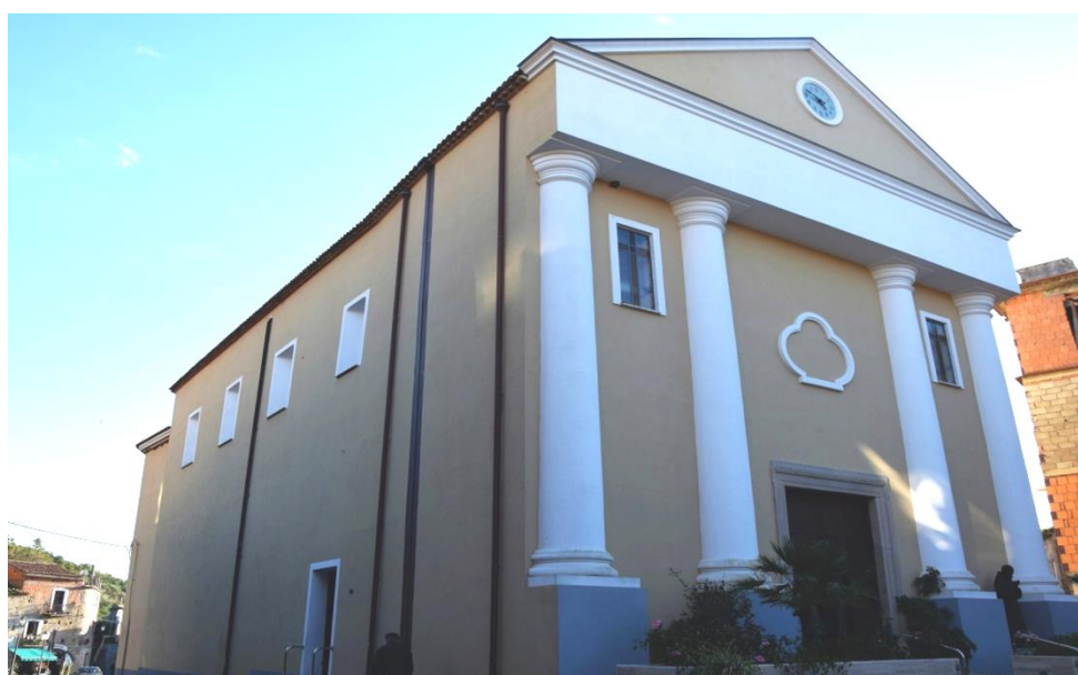
LA CHIESA RISTRUTTURATA E RIAPERTA AL CULTO IL 07 12 2014.
